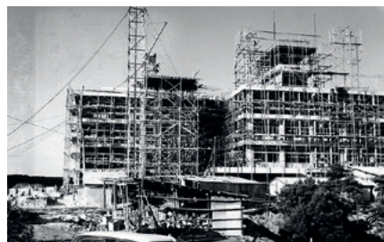
セミナー棟の建設風景
