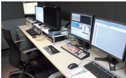
あらゆる動きを制御するコントロール室
